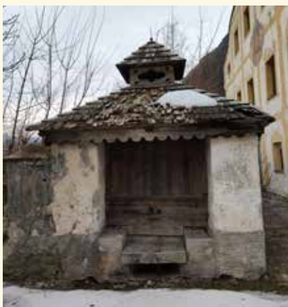
Ziehbrunnen vor der Sanierung
