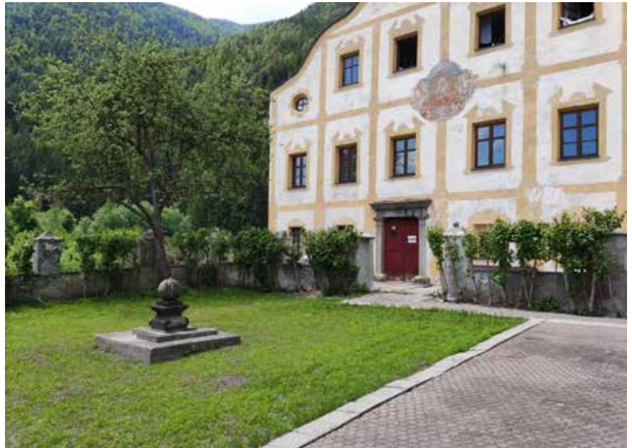
Der Garten nach der Sanierung
