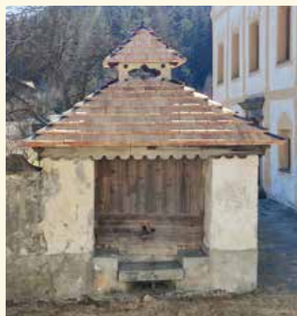
Ziehbrunnen nach der Sanierung
