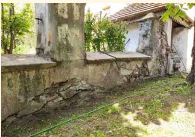
Mauer vor der Sanierung
