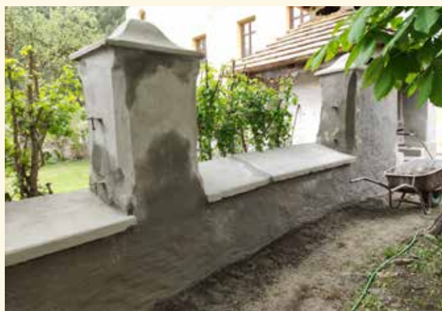
Mauer nach der Sanierung
