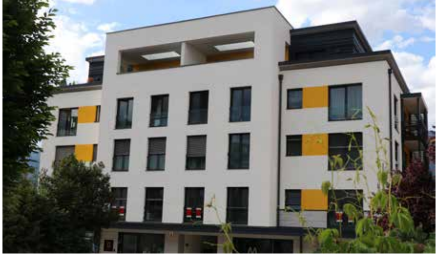
Die Seniorenmensa ist im Gebäude der Alten Gemeinde untergebracht.
